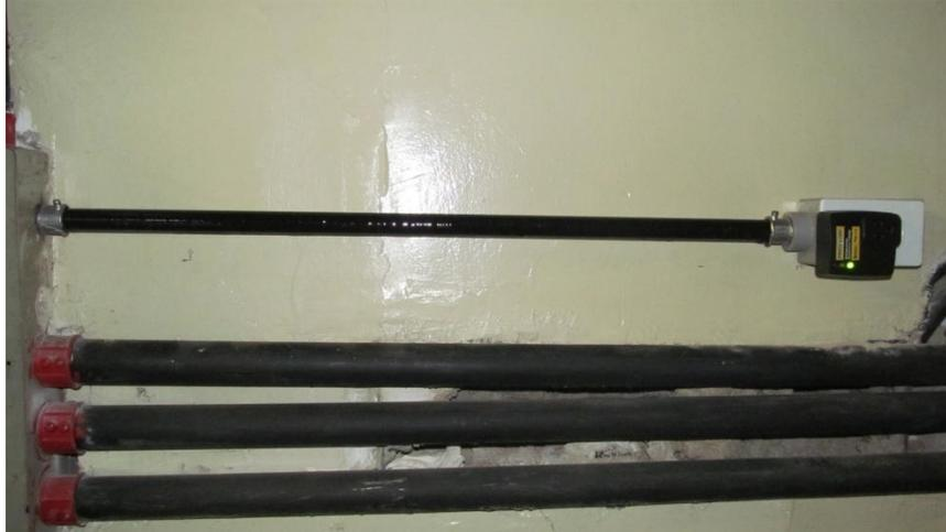
Anexo 6-Instalación Actual: Nueva acometida con cajas condulet FS para tomacorrientes 120V y protectores de voltaje como dispositivos de seguridad.
