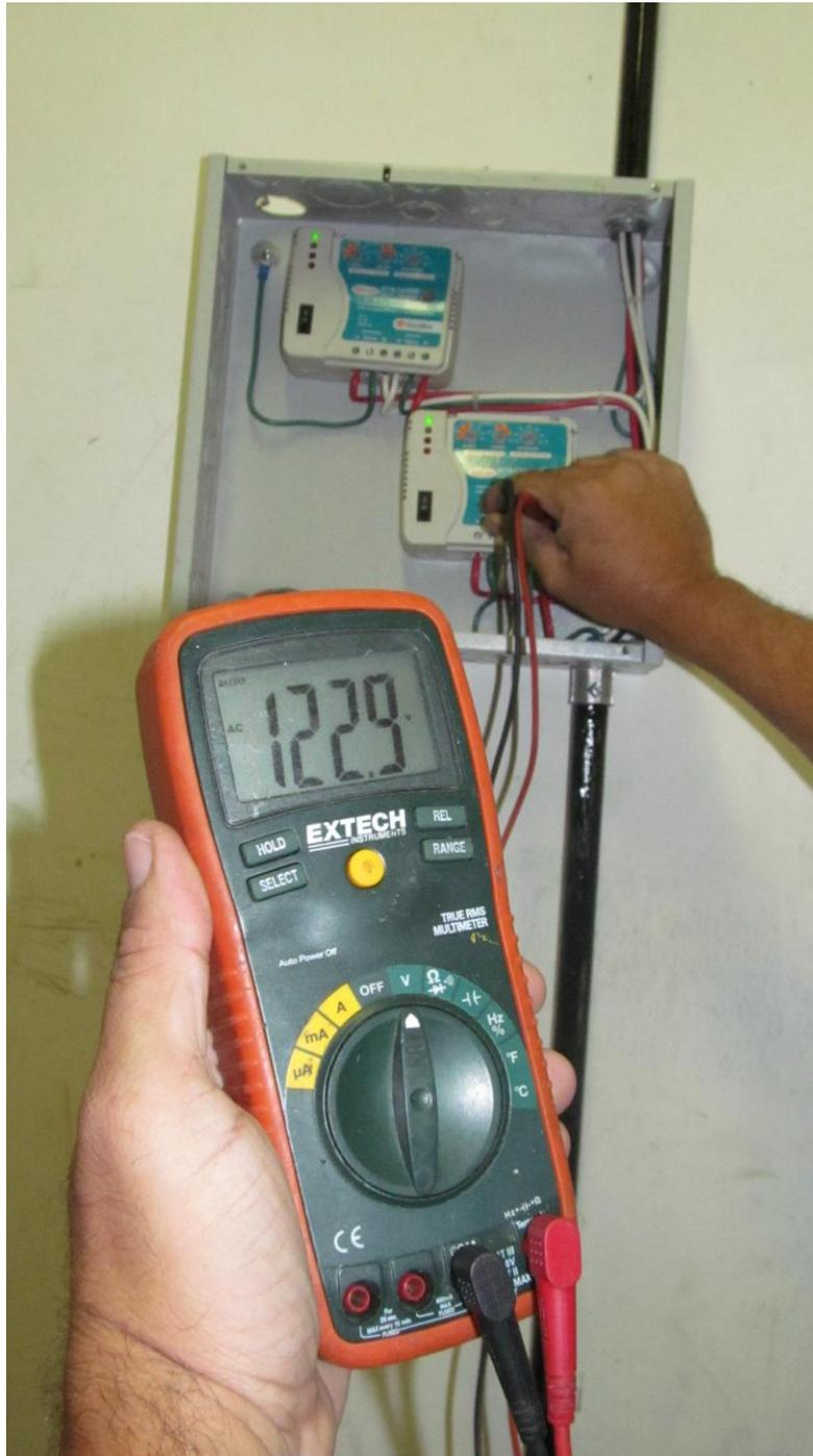
Anexo 6 – **INSTALACIÓN ACTUAL:** Medición de salida en supervisor de fase.
