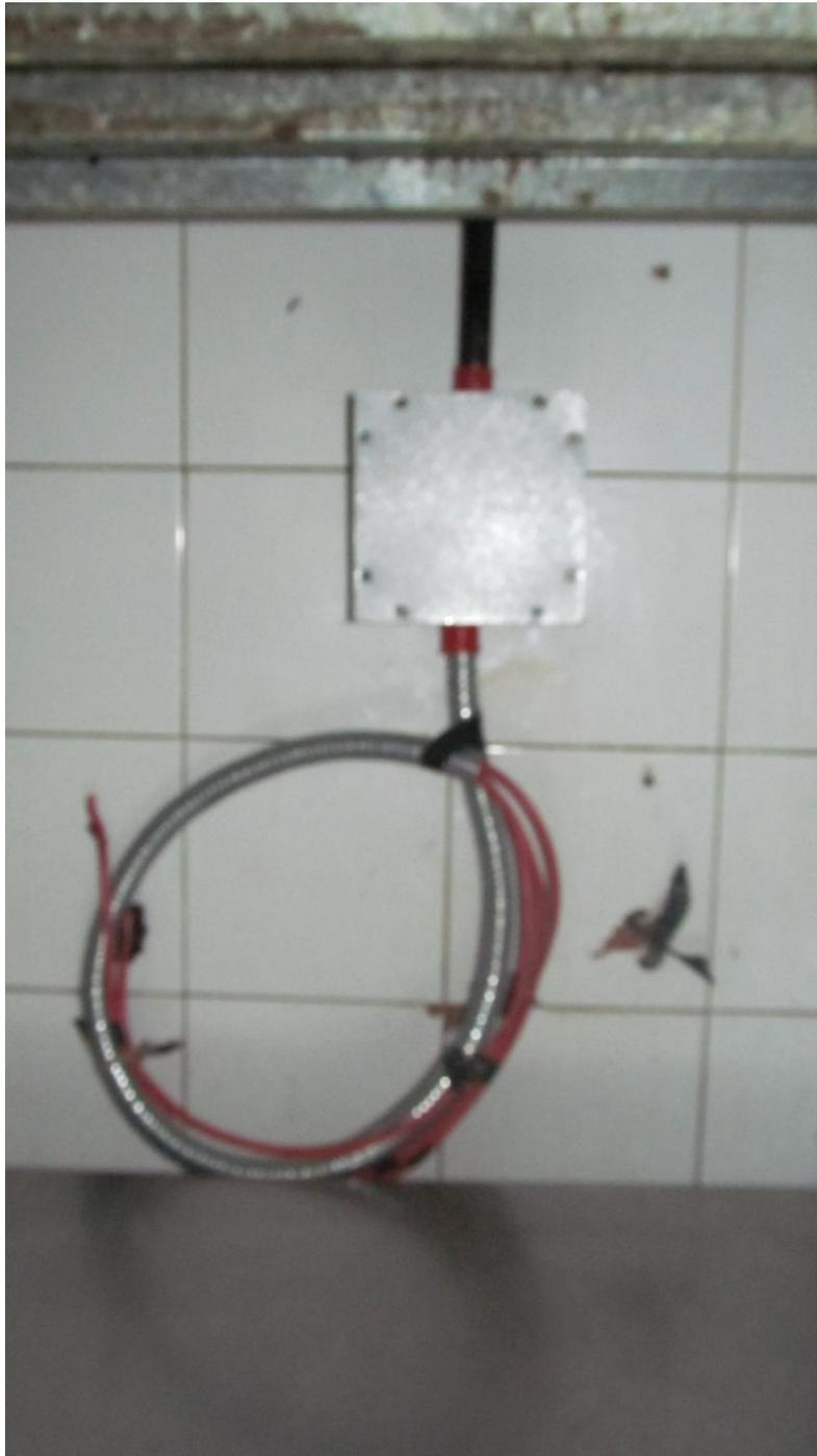
Anexo 5 – **INSTALACIÓN ACTUAL:** Ubicación definitiva, caja 6x6x4, tubería flexible EMT  $\frac{3}{4}$ " para conexión hacia equipo.
