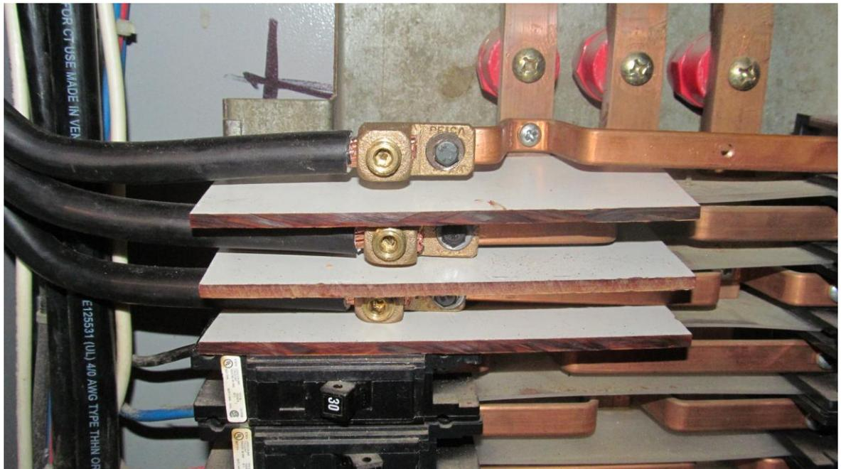
Anexo 4 – **INSTALACIÓN ACTUAL** – Tablero eléctrico T-DUL 1 con conductores 2/0 AWG conectados a barras y con baquelita para aislamiento
