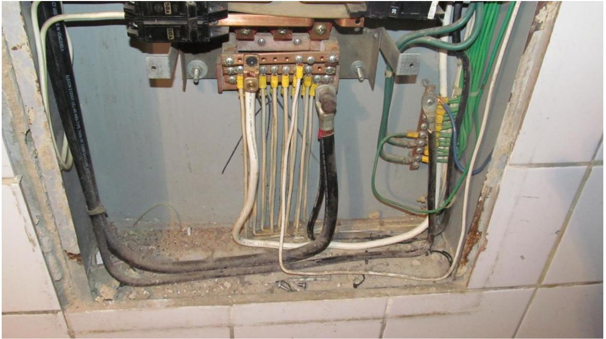
**Anexo 5 – INSTALACIÓN ACTUAL** – Barra de neutro y tierra en tablero eléctrico T-DUL 1 con conductor # 2 AWG
