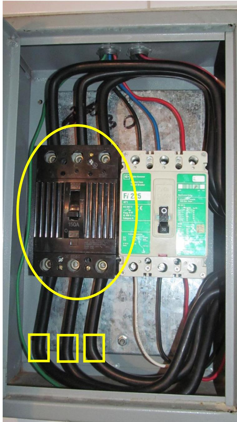
Anexo 2 – **INSTALACIÓN ACTUAL** – Tablero eléctrico con instalación de breaker 150 A, conductores 2/0 AWG
