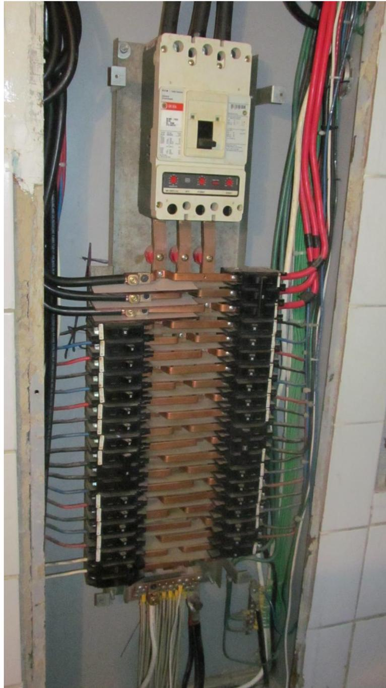
**Anexo 3 – INSTALACIÓN ACTUAL** – Tablero eléctrico T-DUL 1 con conductores 2/0 AWG conectados a barras y con baquelita para aislamiento
