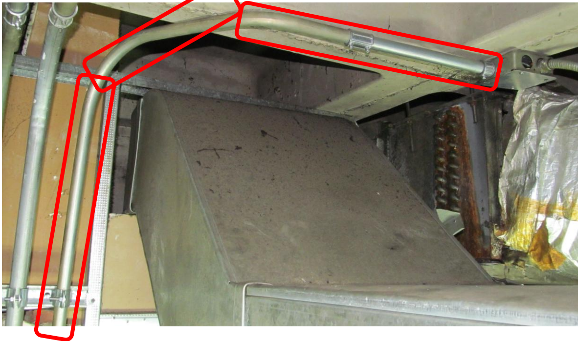
Anexo 9 – Acometida eléctrica – Trayecto 4: Ramificación hacia turbina con caja 4x4 y tubería flexible hacia equipo
