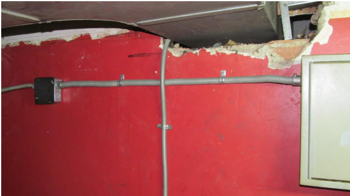
Anexo 9 – Acometida eléctrica – Trayecto 4: Ramificación hacia turbina con caja 4x4 y tubería flexible hacia equipo
