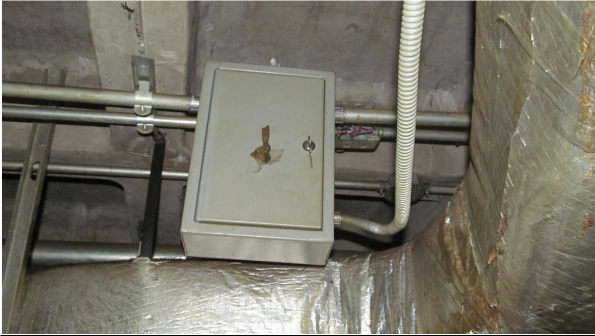
Anexo 3 - Tablero 2: Ubicación antigua
