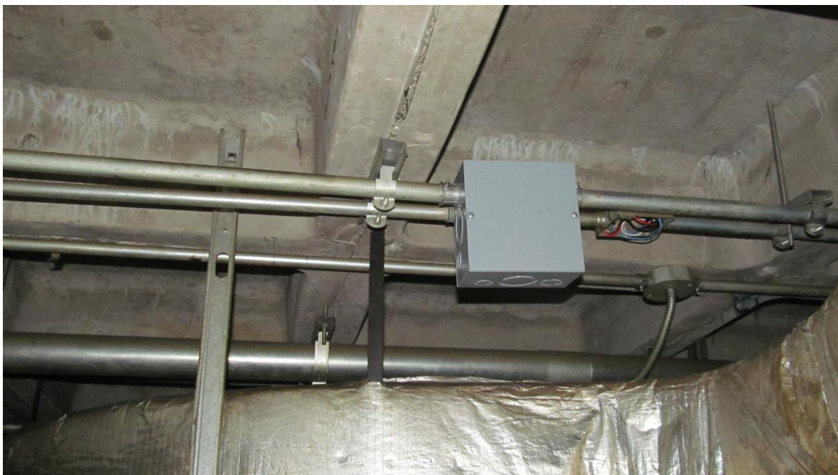
Anexo 5 – Instalación de caja de paso 6x6x4 para ramificación de tablero 1 y prolongación de tablero 2
