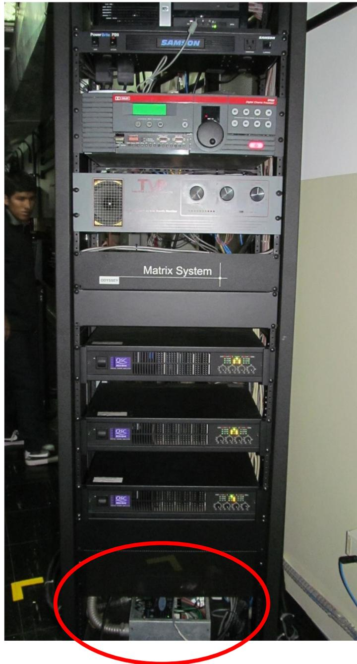
Anexo 1 – Rack de sonido: Caja de paso con supervisor de fase y borneras 208V y 120V
