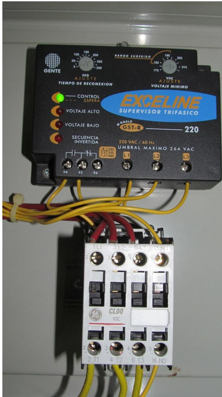
Anexo 3 – Supervisor de fase y contactor (Conexión antigua): Alimentación Rack de sonido
