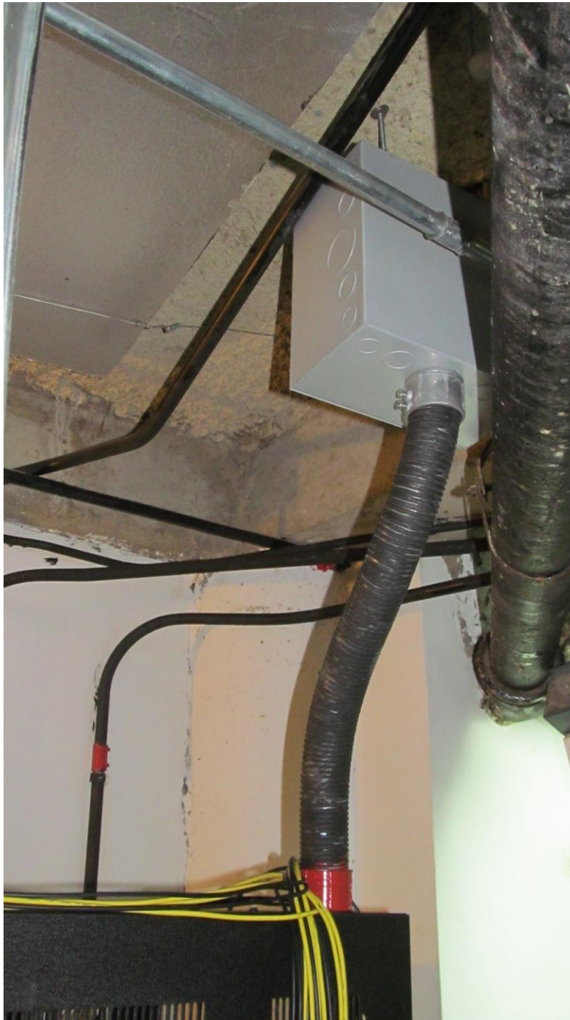
Anexo 8 – Rack de sonido Sala 5: Prolongación de tubería 2” para movilización de rack de sonido, instalación de caja de paso 10x10x6
