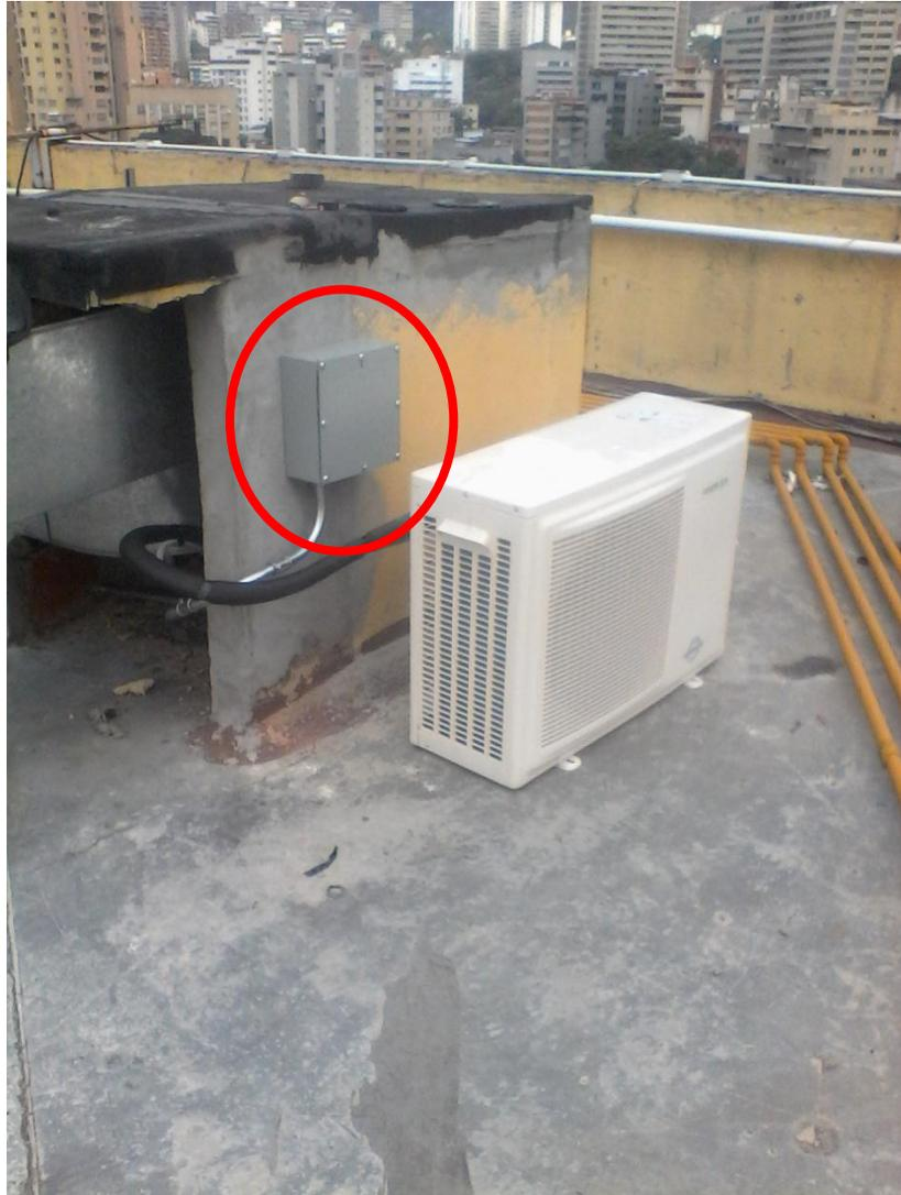
Anexo 10 – Azotea: Instalación de caja 6x6x4 para intemperie, alimentación a unidad condensadora.
