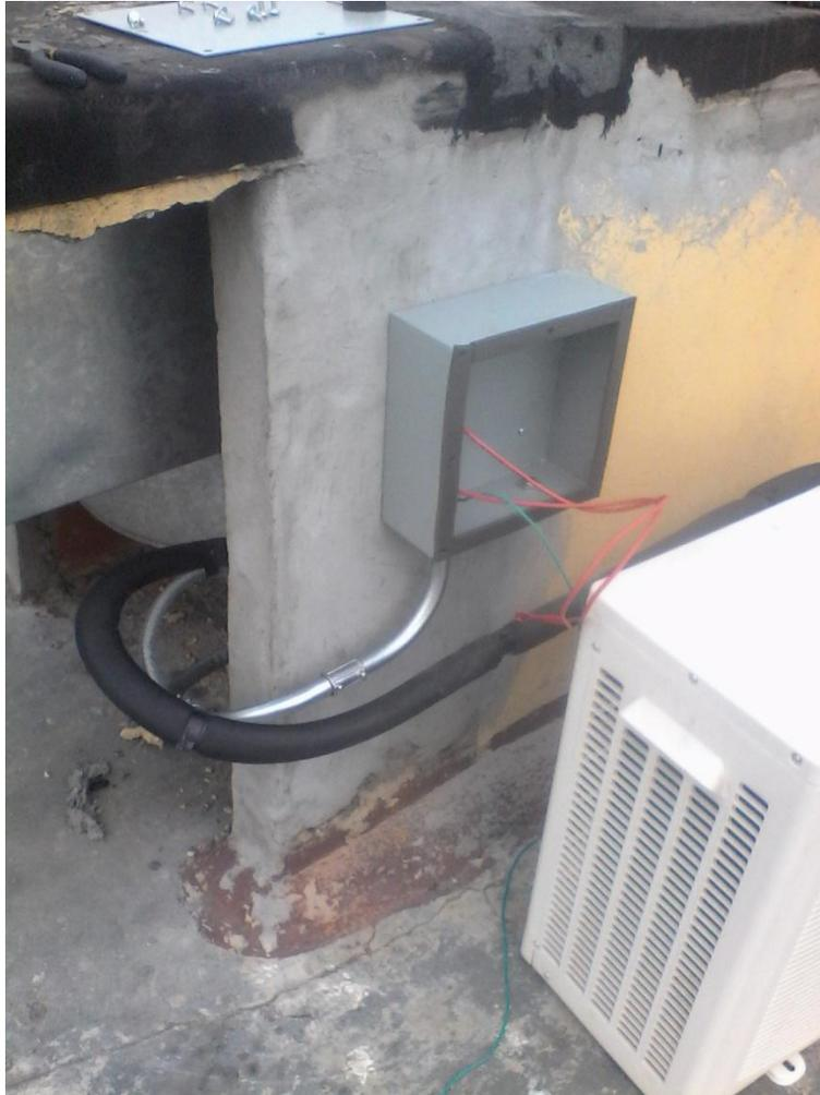
Anexo 11 – Azotea: Instalación de acometida para alimentación a unidad condensadora.
