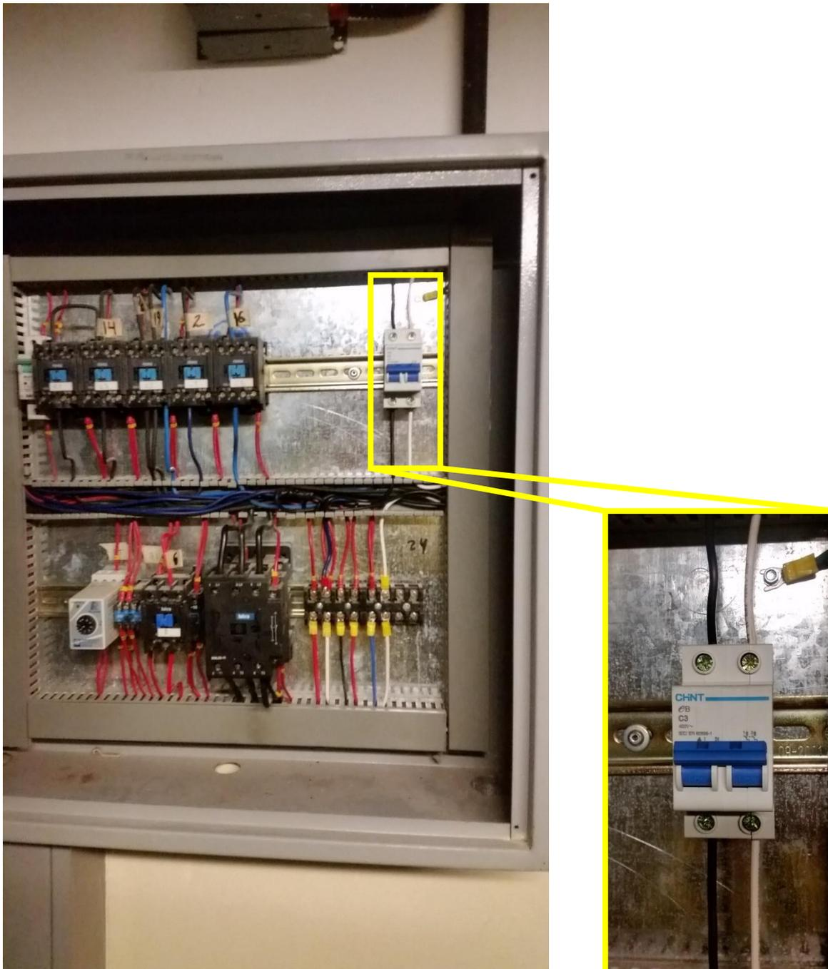
Anexo 7 – **INSTALACIÓN ACTUAL SALA 9:** Tablero de control y breaker de protección 3 A
