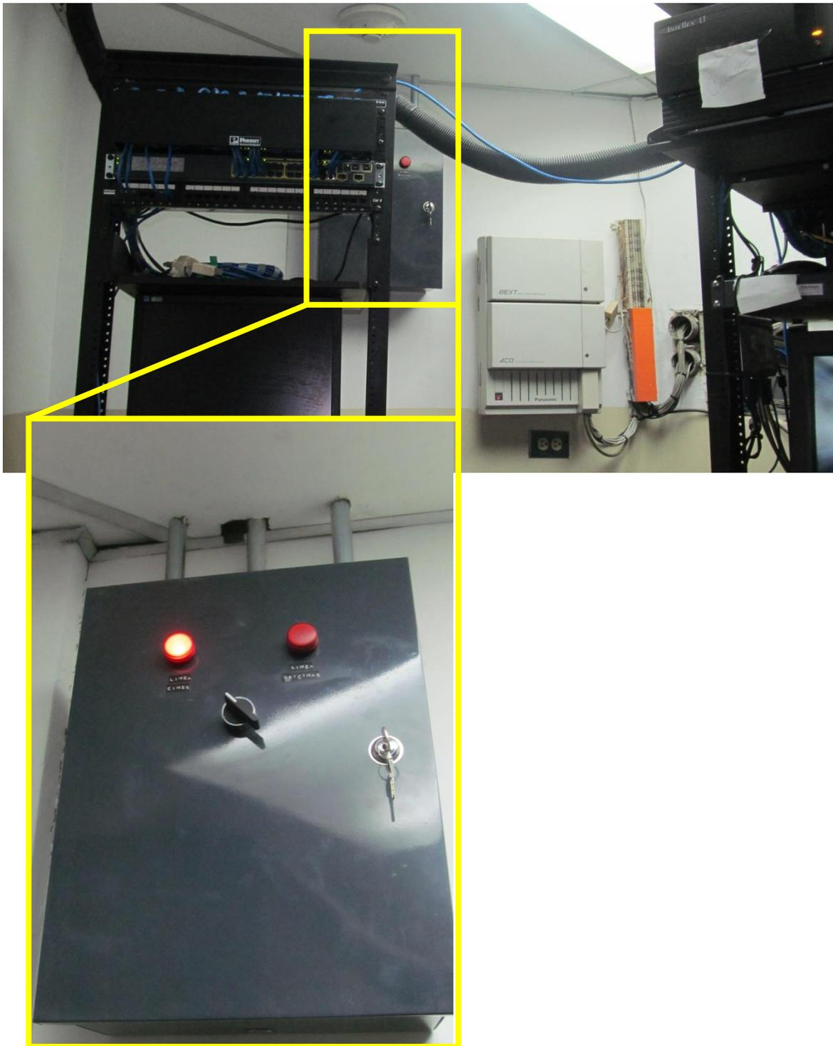
Anexo 12 – **INSTALACIÓN ACTUAL:** Tablero para control de alimentación eléctrica de TEPS, TAQUILLA y SERVIDORES
