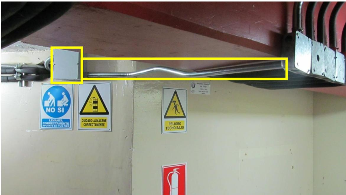
Anexo 4 – **INSTALACIÓN ACTUAL:** Acometida eléctrica desde Tablero T-VES 1 en depósito principal. Comunicación con área técnica.
