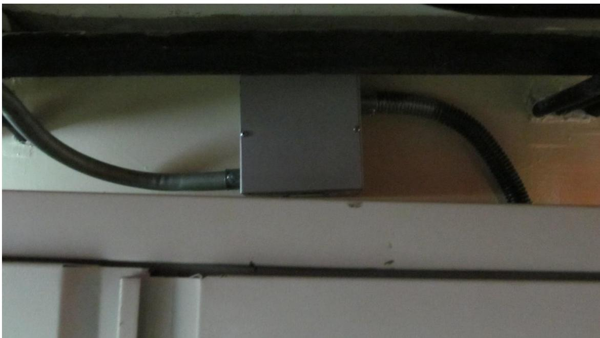
Anexo 2 – **INSTALACIÓN ACTUAL:** Caja de paso para comunicación desde Tablero T-VES 1 hacia depósito principal
