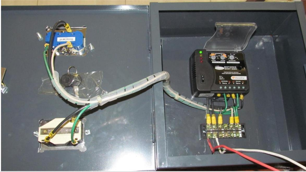
Anexo 2: Tablero 2 – Lado Interno (Supervisor de fase, bornera, conexiones en tomacorriente 270 cooper y NEMA L6)
