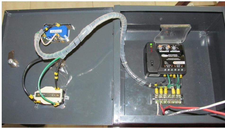
Anexo 2: Tablero – Lado Interno (Supervisor de fase, bornera, conexiones en tomacorriente 270 cooper y NEMA L6)
