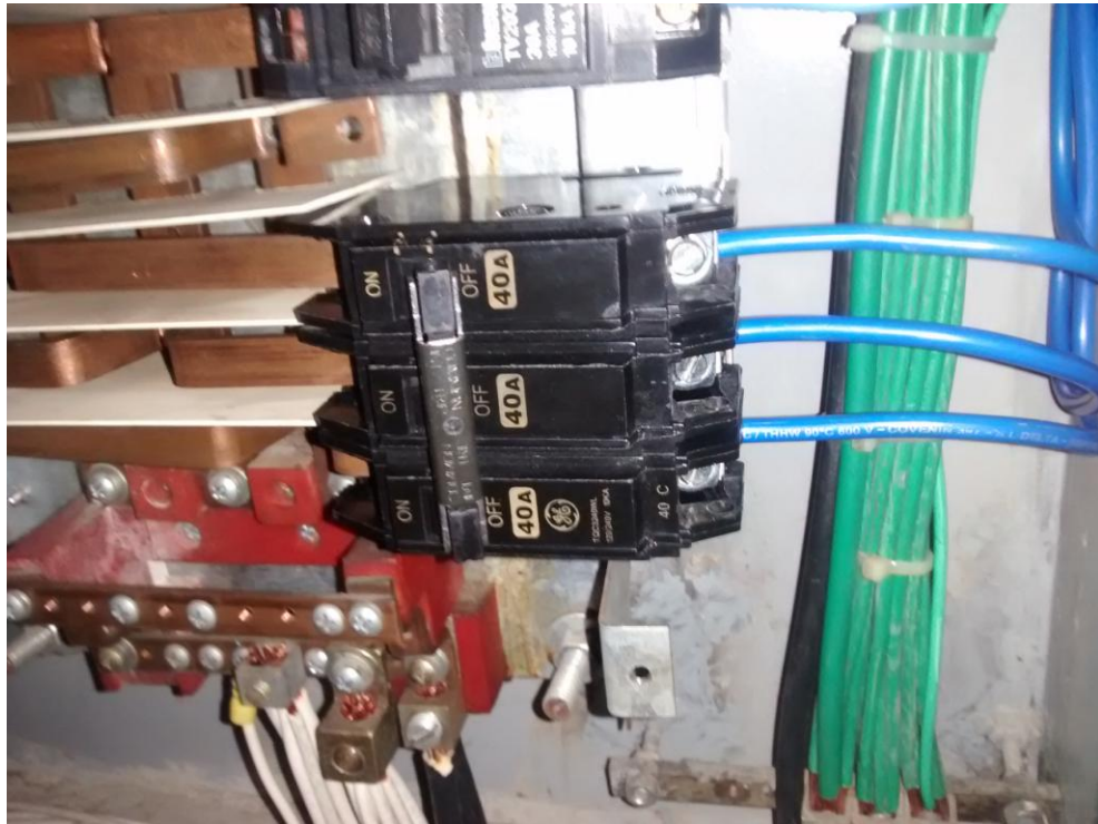
Anexo 5 – Tablero eléctrico: Instalación de breaker 3x40A
