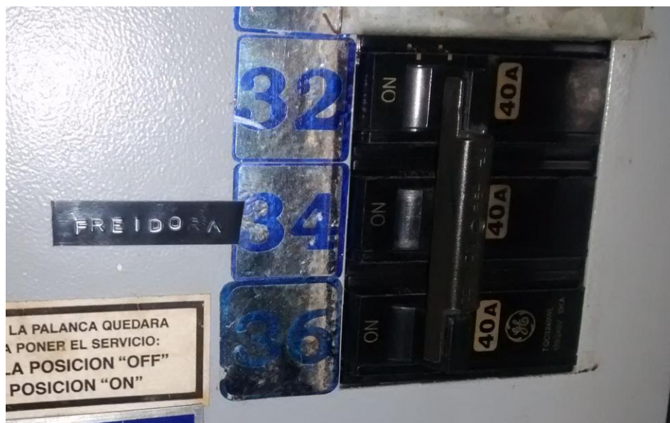
Anexo 5 – Tablero eléctrico: Instalación de breaker 3x40A
