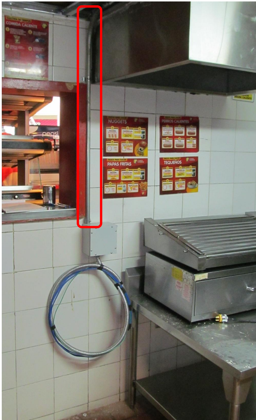
Anexo 7 – Acometida eléctrica 208V: Canalización hacia equipo
