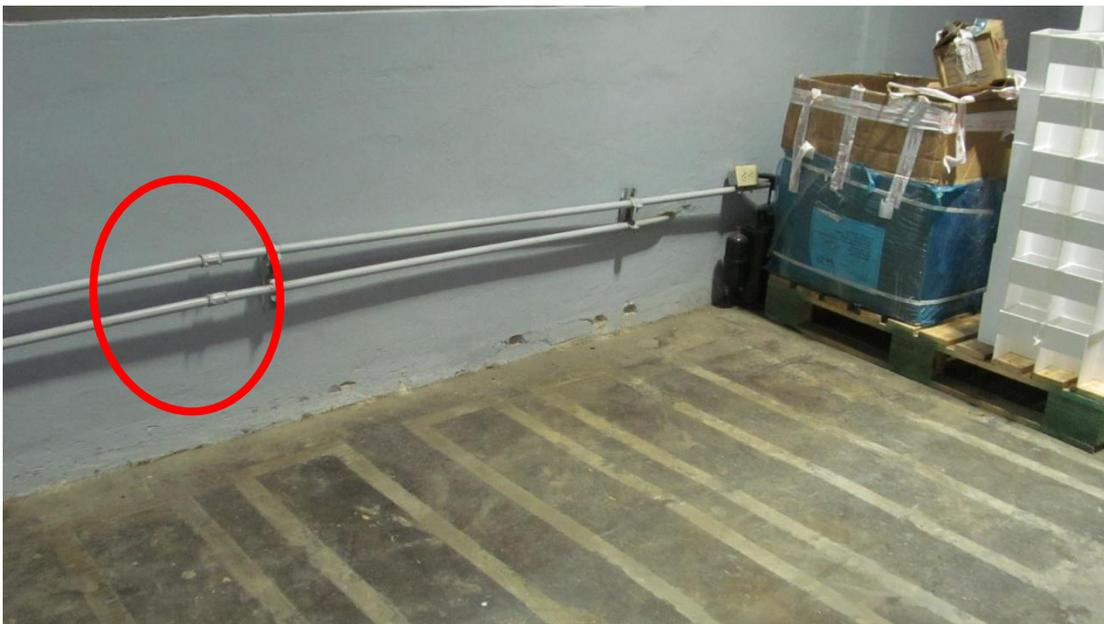
Anexo 7 – Acometida eléctrica – Trayecto 3 horizontal, 7m. Punto de conexión eléctrica hacia el equipo.
