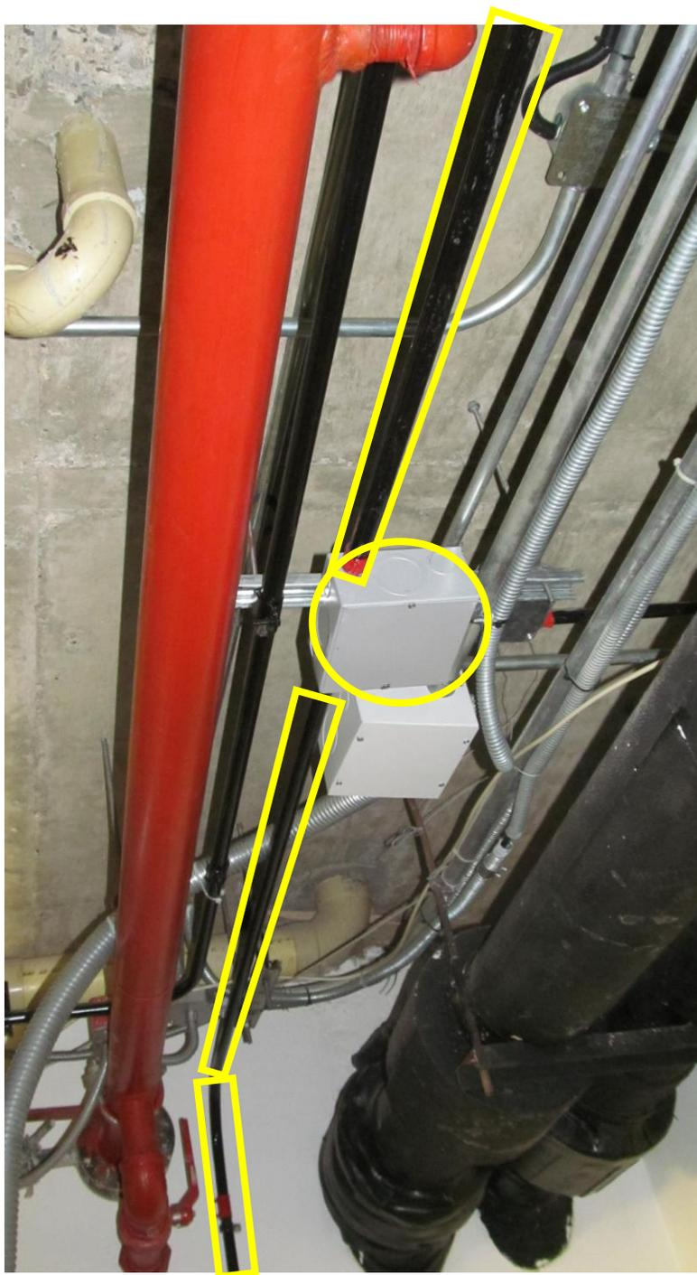
Anexo 9 – **INSTALACIÓN ACTUAL:** Trayecto 4 – Dentro del área del TMS, instalación de caja de paso
