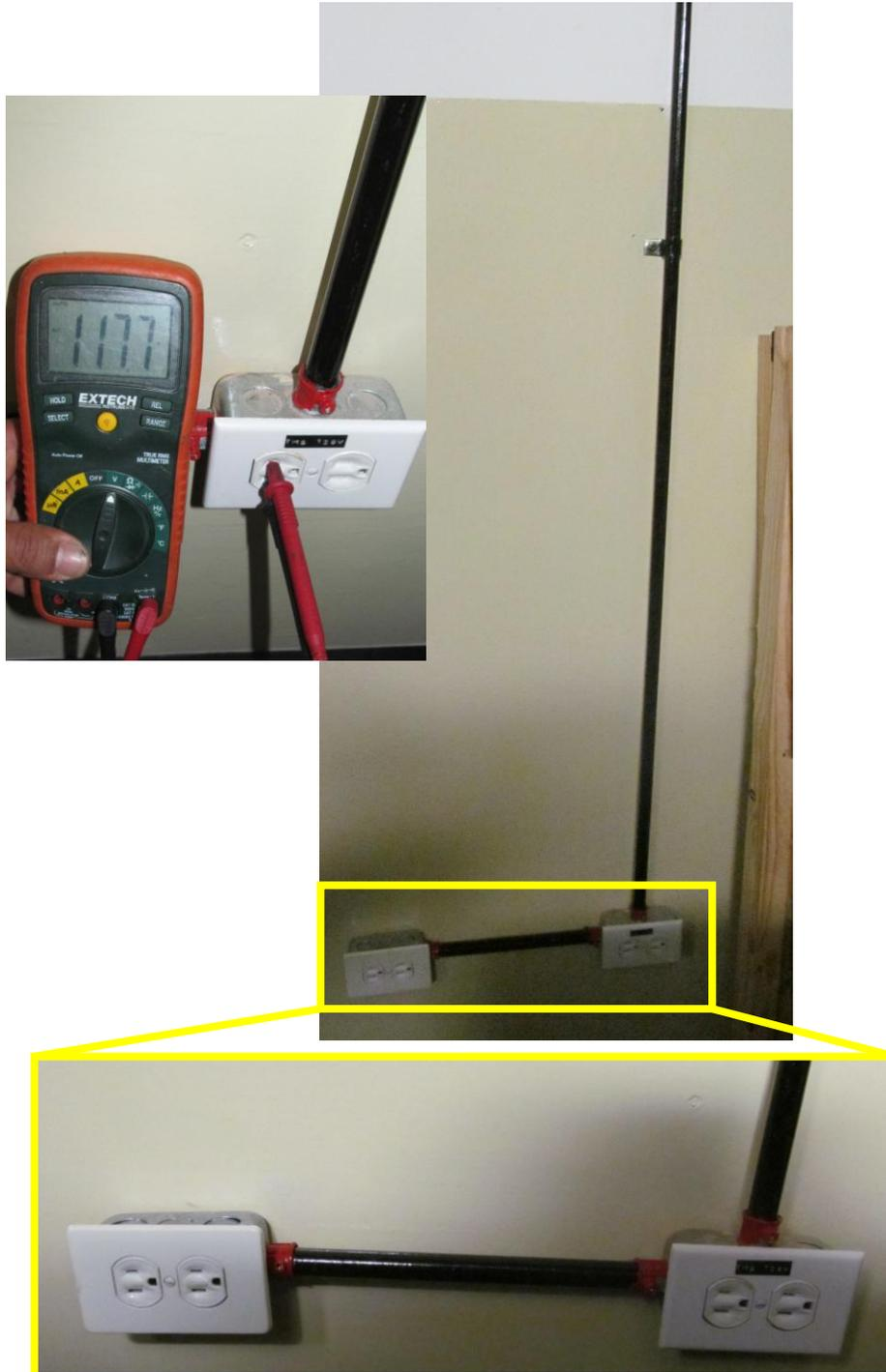
Anexo 11 – **INSTALACIÓN ACTUAL:** Trayecto 4 – Dentro del área del TMS, instalación de tomas L5 30 R
