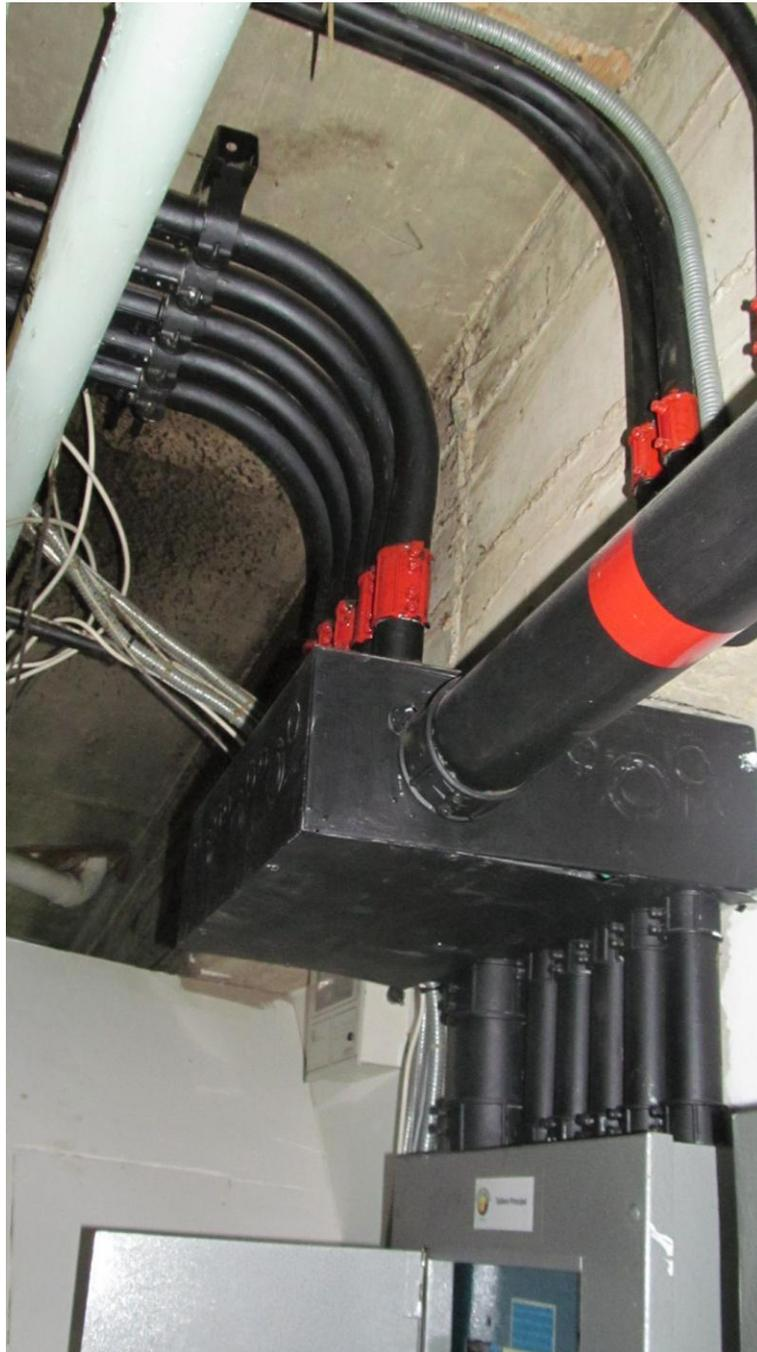
Anexo 3 – **INSTALACIÓN ACTUAL:** Trayecto 1 – Salida del tablero a caja de paso instalada
