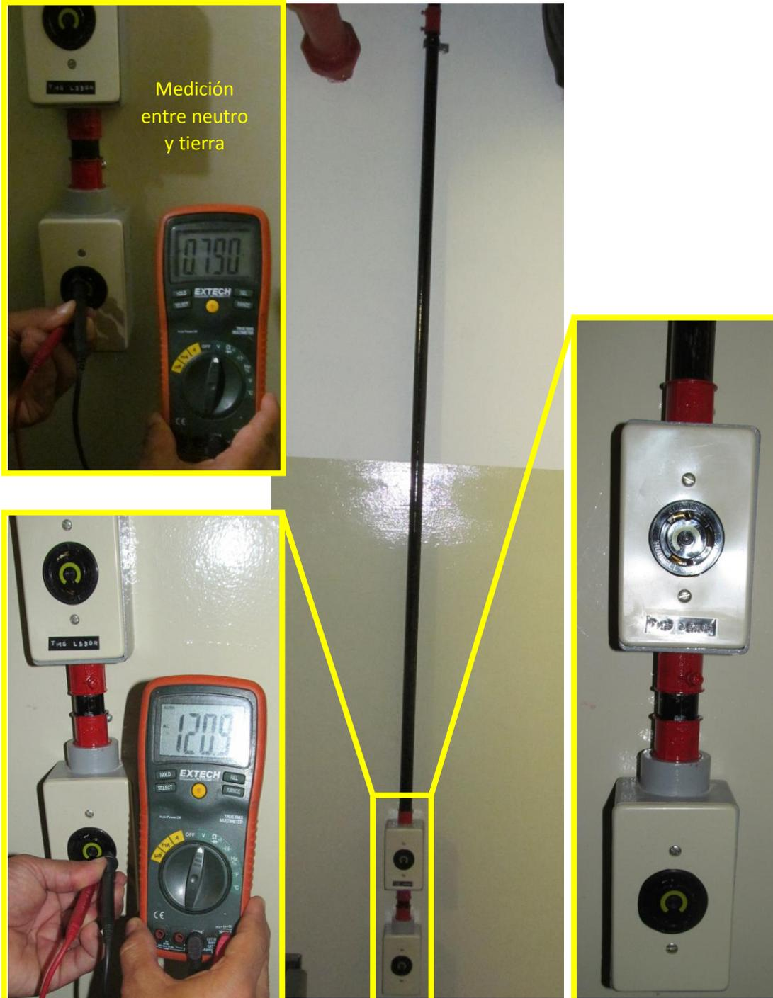
Anexo 10 – **INSTALACIÓN ACTUAL:** Trayecto 4 – Dentro del área del TMS, instalación de tomas L5 30 R
