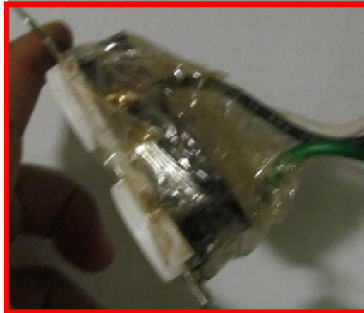
**Anexo 12 - INSTALACIÓN ANTIGUA:** Tomacorriente instalado 120V con adaptador. Tensión de trabajo en la unidad evaporadora 208V que representaba un riesgo de posible daño de algún equipo por alimentación inadecuada.
