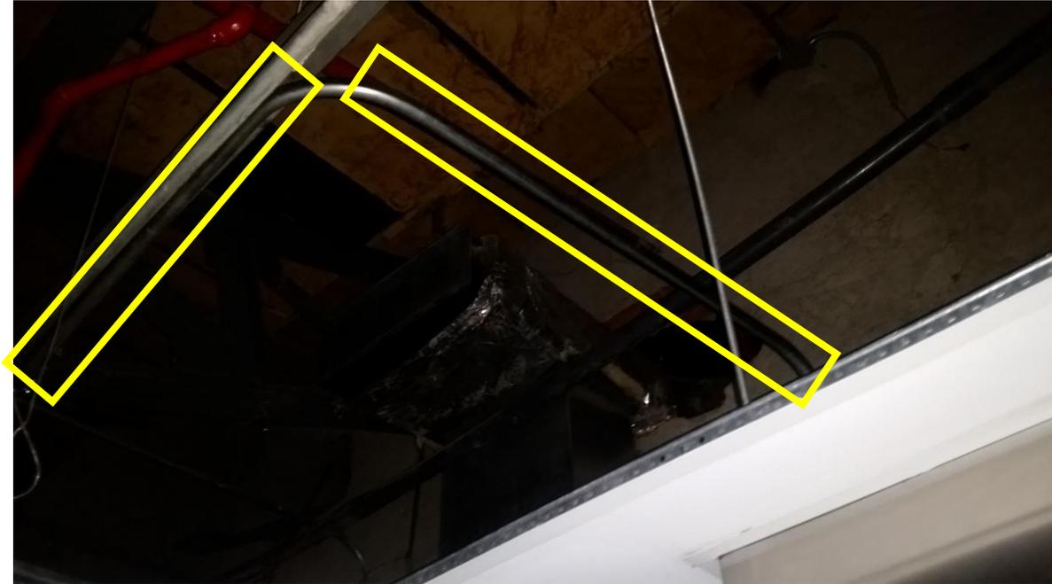
Anexo 3 y 4 – **INSTALACIÓN ACTUAL**: Acometida eléctrica instalada sobre cielo raso
